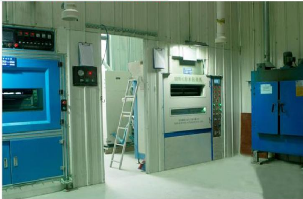
工厂车间图：环氧封装站
