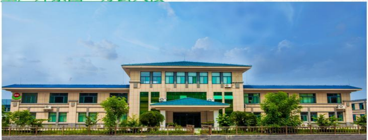
工厂外景图：办公大楼
