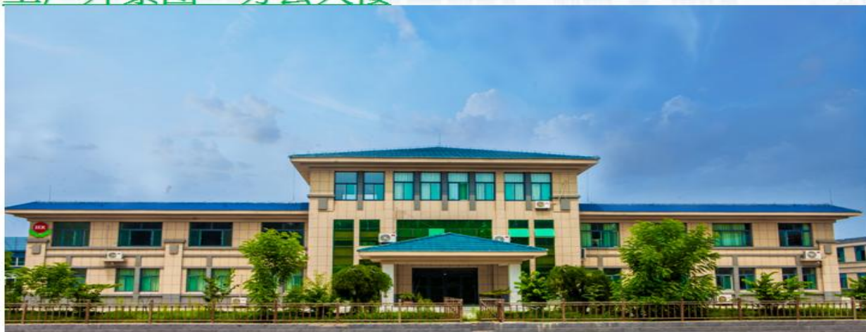
工厂外景图：办公大楼
