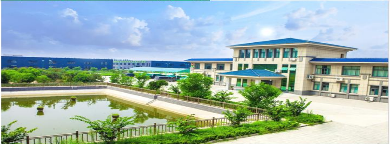
工厂外景图：工厂侧视全景
